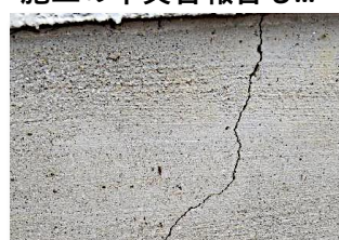
例：コンクリートのひび割れ
