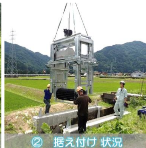
② 据え付け 状況
