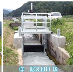
③ 据え付け 後
