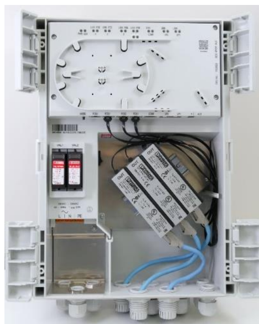
RJ45サージ保護機器 設置例
